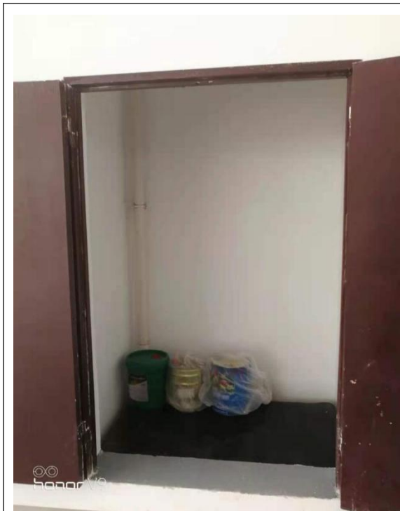
废油桶下面设置塑胶垫层防止泄漏
