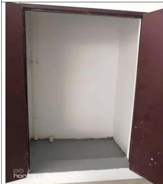
危废暂存间地面做防腐、硬化、防渗处理
